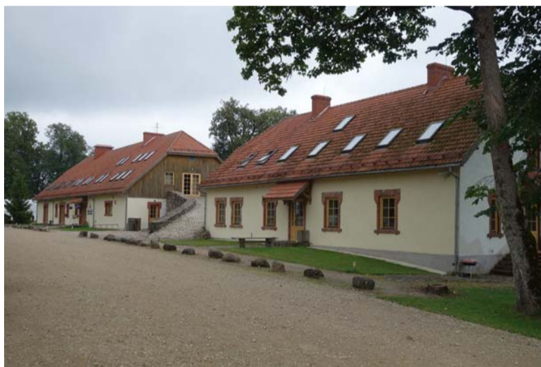
Atpūtas kompleksa „Jumurdas muiža” administrācijas ēka un viesu māja, 2019. gads. Z. Saulītes foto
