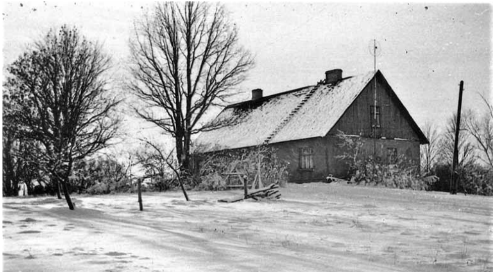
Mājas „Itālija”, 1973. gads. Kādreizējā Itālijas pusmuižas klēts, 1920. gados pārtaisīta par dzīvojamo māju. Pēc 2. pasaules kara te dzīvojušas vairākas ģimenes. Foto no Valda Zirņa personīgā arhīva.
